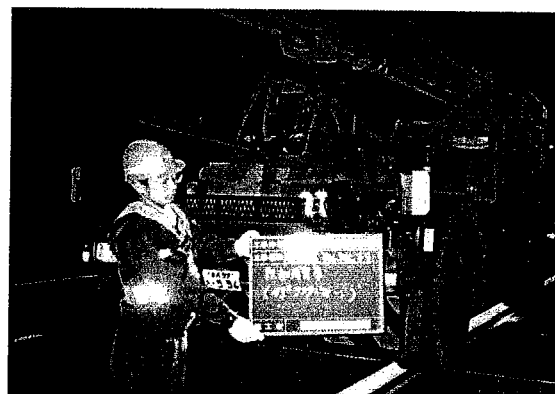
写真－３ 45t ラフタークレーン載荷状況
