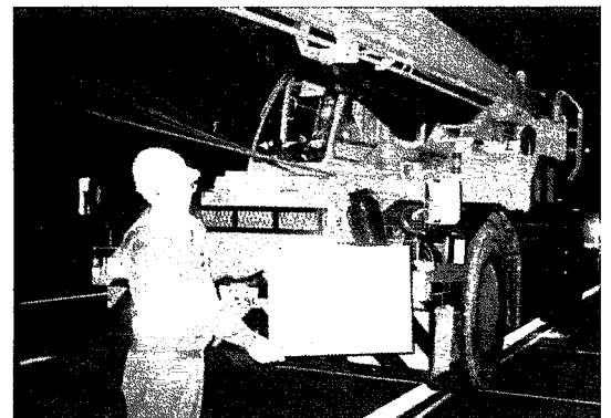
写真－1 45t ラフタークレーン載荷状況
