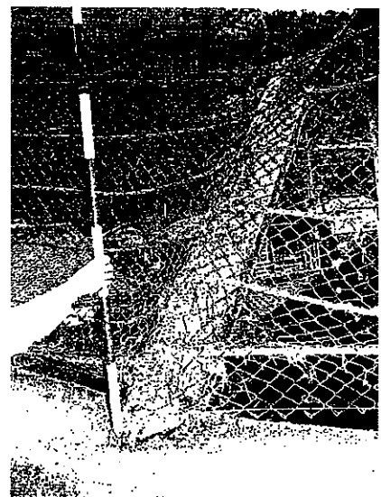
写真-2 落石防護柵の被災状況 (支柱②)
