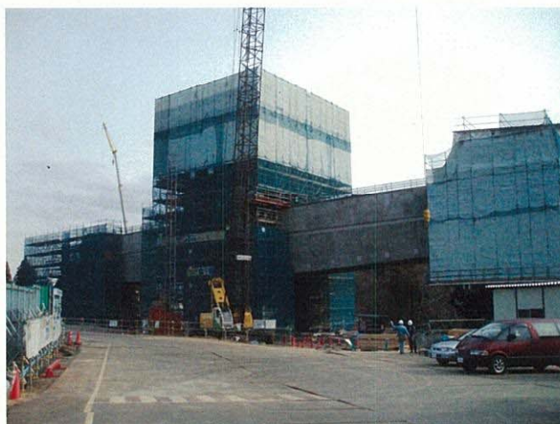
図－15 現況写真（P2橋脚）
