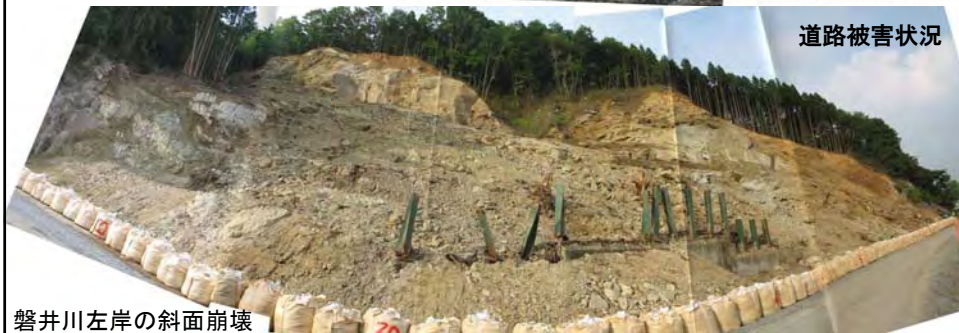
磐井川右岸の斜面崩壊に伴う河道閉塞
