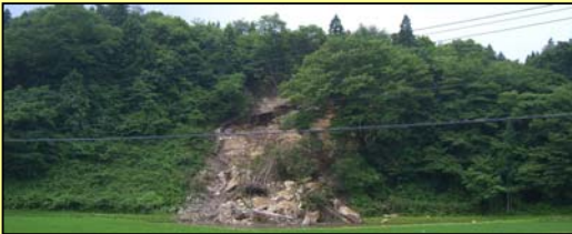
⑥(一関市厳美町柵木立:県道沿い) 地表地震断層沿いの斜面崩壊
