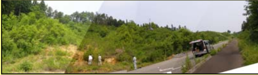
⑨(栗原市栗駒沼倉:県道沿い) 地表地震断層延長沿いの地すべり
