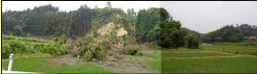
⑧(一関市厳美町柵木立:県道沿い) 地表地震断層延長沿いの斜面崩壊
