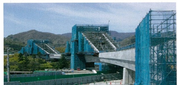
写真-9 施工中の第二吾妻川橋梁
