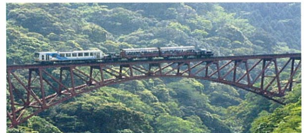
写真-2 第1白川橋梁
