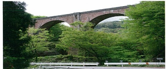
写真-1 碓井峠第3橋梁
