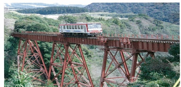
写真-3 立野橋梁
