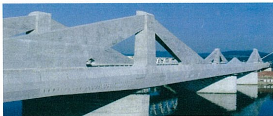
写真-6 川内川橋梁
