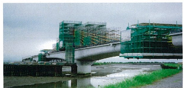
写真-8 施工中の大野川橋梁
