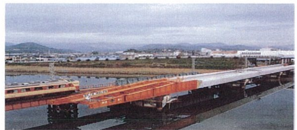
写真-4 施工中の汐見川橋梁
