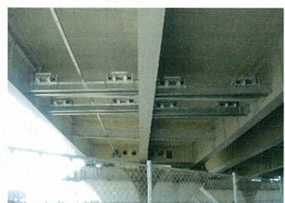
写真-6 TMD全景
