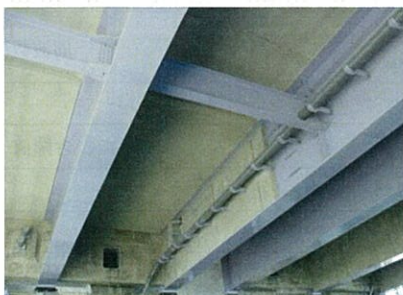
写真-4 増厚、巻立て全景
