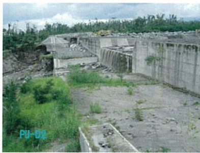
写真-4 袖部土石流越流による損壊 写真-5 巨礫衝突による破損(1) 写真-6 巨礫衝突による破損(2)
