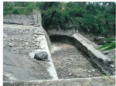
写真-4 袖部土石流越流による損壊 写真-5 巨礫衝突による破損(1) 写真-6 巨礫衝突による破損(2)
