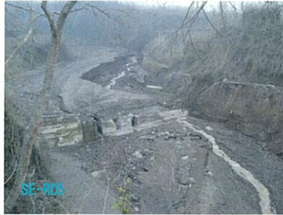
写真-4 袖部土石流越流による損壊 写真-5 巨礫衝突による破損(1) 写真-6 巨礫衝突による破損(2)
