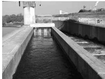
写真-1 A 地点(水車設置水路(左)と魚道(右))
