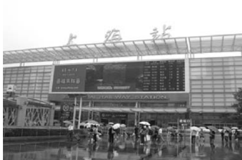
写真-3 上海駅外観
