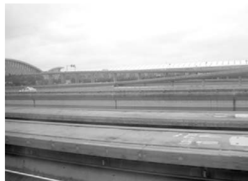
写真-10 上海トランスラピッド軌道
