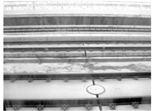
写真-8 高速鉄道軌道
