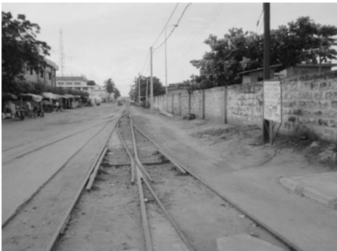
写真-7 道路脇の軌道敷設
