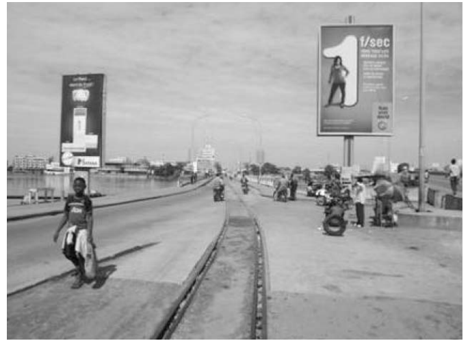
写真-6 道路と鉄道軌道が共有する橋梁
