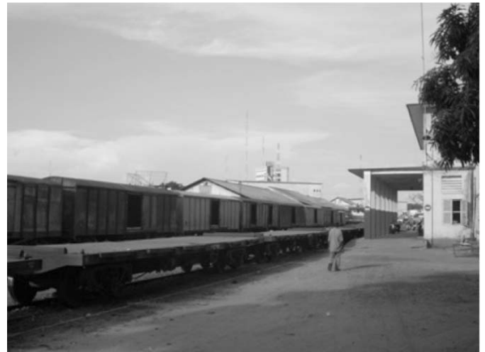
写真-10 コトヌー駅構内
