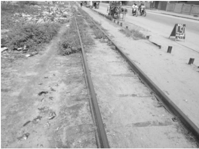
写真-5 軌道の状態
