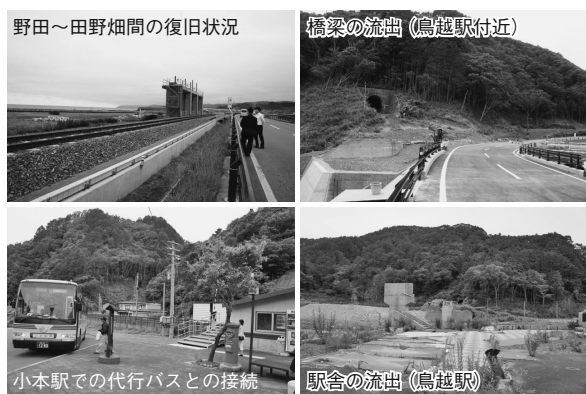
図2 各地区の被災状況 【2012年7月22日、撮影者：森】
