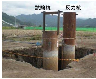
写真-1 試験杭の状況
