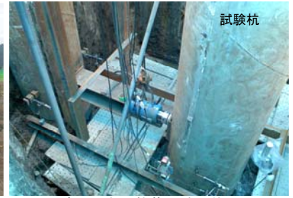
写真-2 水平載荷試験の状況
