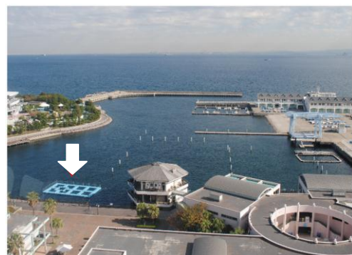
図-11 実証実験施設の設置状況
