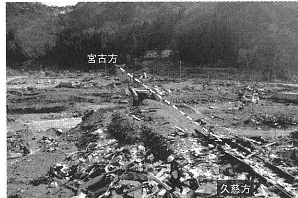
図-5 島越地区の被災状況
