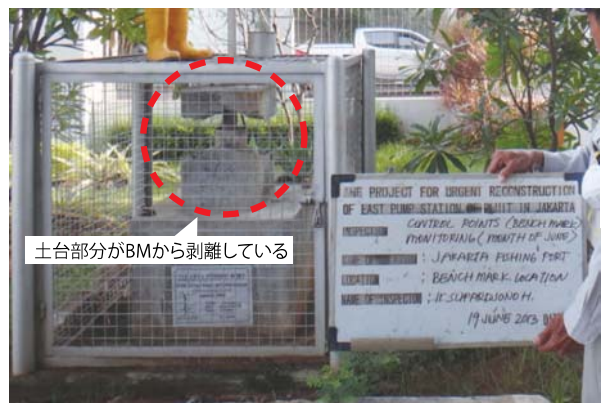
写真-5 ベンチマーク(BM)と周辺地盤との相対沈下の例
