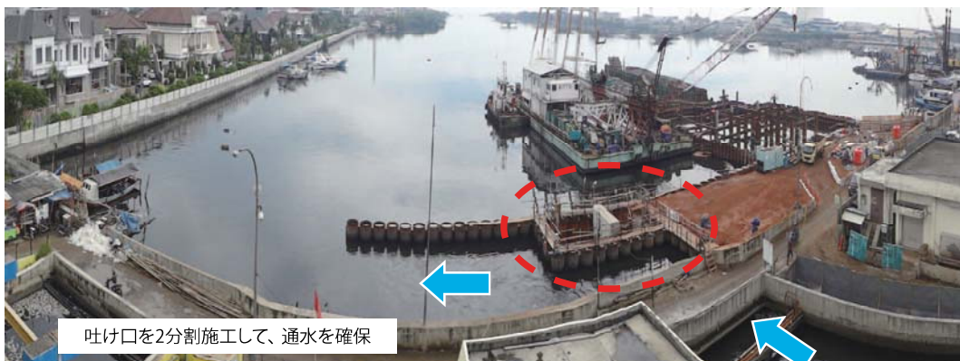
写真-6 中央排水機場前面の 吐け口の分割施工
