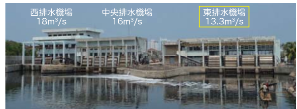
写真-2 プルート排水機場全景
