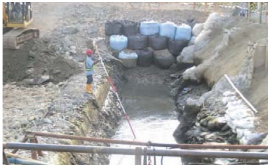
写真-3 鋼管矢板打設ライン上の試掘調査
