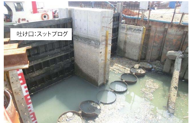
写真-4 中央排水機場吐け口全景
