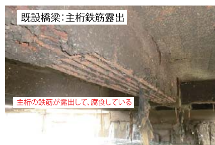
写真-7 中央排水機場吐け口前の橋梁内部
