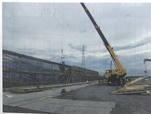
写真 - 5 PC 桁製作
