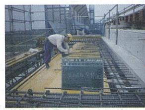
写真-1 張出し床版配筋作業
