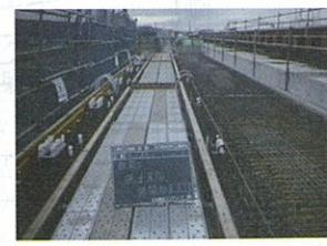
写真-2 張出し床版配筋状況
