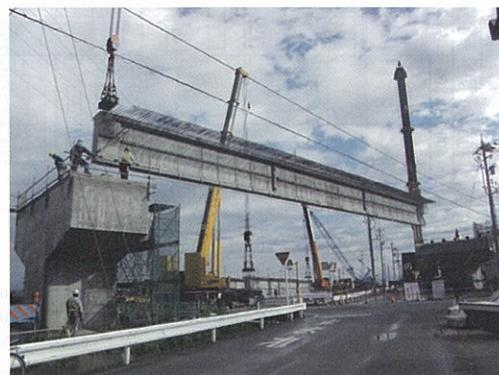
写真 - 6 PC 桁架設
