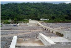
写真-1 防災事業で完成した砂防堰堤の堆積状況
