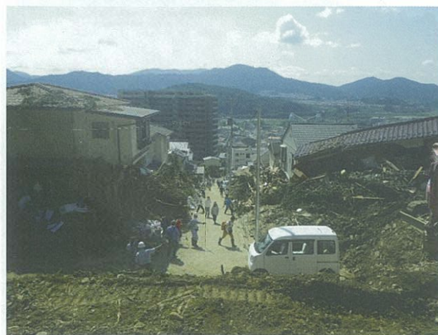
写真-13 阿武の里団地に流入した土石流 勾配12°の道路沿いを流下した
