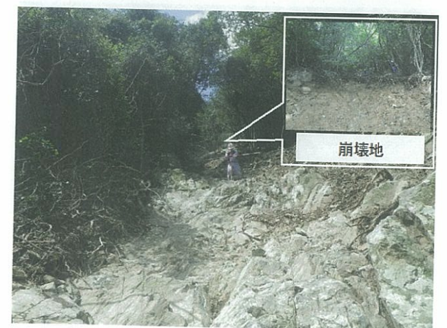
写真-6 太田川支川 75 の源頭部の状況
