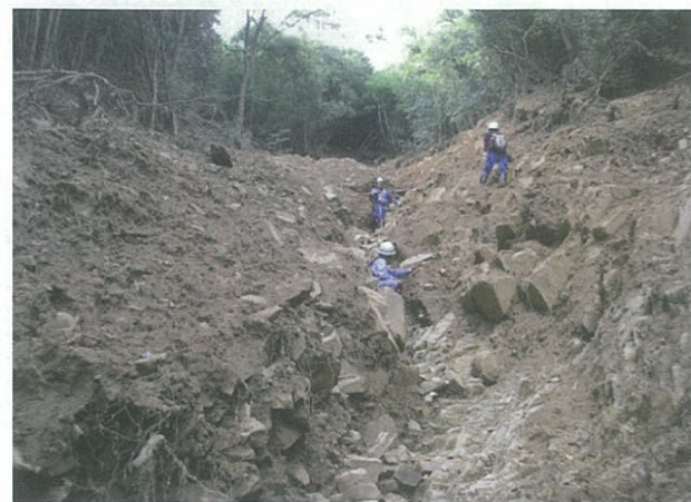
写真-1 根谷川支川 97 の源頭部の様子
