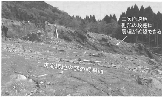
写真-1 二次崩壊地内部の緩斜面と層理
