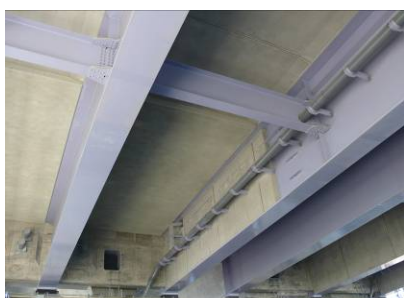
写真-4 増厚、巻立て全景
