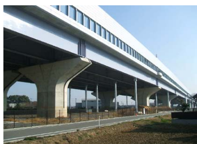
写真-5 センターダンパー全景
