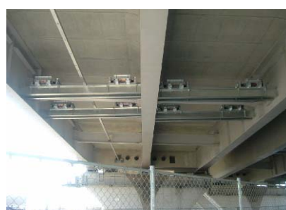
写真-6 TMD全景
