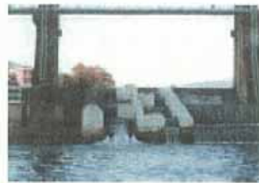
写真-1 魚道入口の高落差
