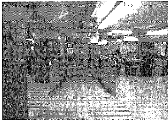
写真1 エレベーター設置の工夫 (床高を下げ省スペース型エレベーターを設置) 阪急京都線 烏丸駅 出典：阪急電鉄(株)提供
