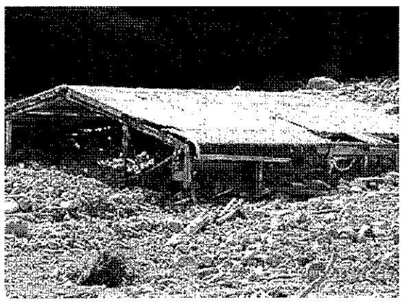
写真-7 土砂堆積により埋没した施設 (流路C)
