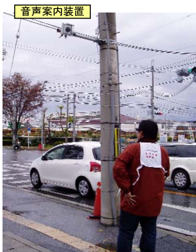
写真－１ 音声案内装置の設置状態
