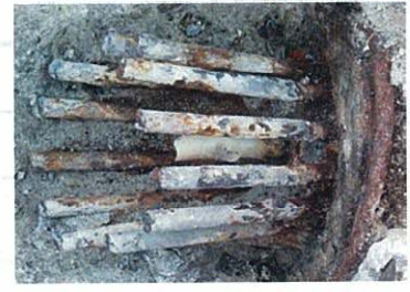
写真-8 PC鋼材上縁定着部はつり
