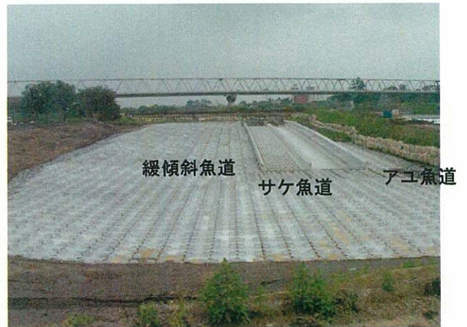
図4 水海道魚道の改造前後の平面とアユ・サケ魚道形状
