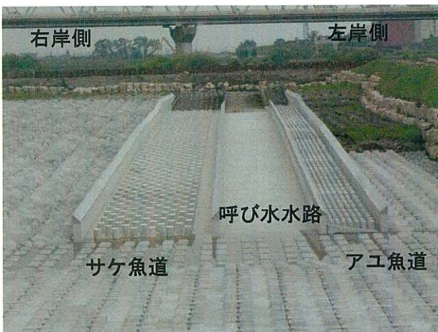
図4 水海道魚道の改造前後の平面とアユ・サケ魚道形状
