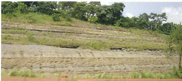
図-6 南部エヌグ州の道路法面においてみられた白亜系の砂岩優勢砂岩泥岩互層（位置を図-3 に示す）
