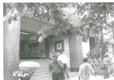
写真-4 地下鉄の地上出入口
