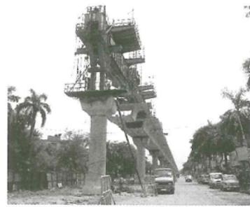
写真-5 建設中の東西線高架区間
