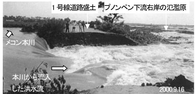
写真-2 カンボジア国道1号線盛土道路を挟んで生じた水位差
