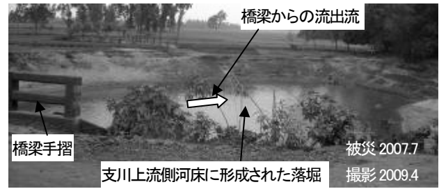
写真-5 カルバート橋の支川上流側河床に形成された落堀
