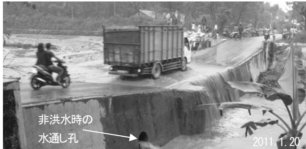
写真-8 インドネシア メラピ山溪流の橋梁兼用砂防ダム(越流の様子)
