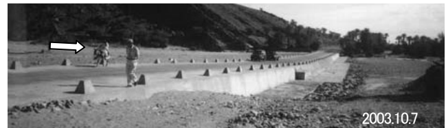
写真-7 モロッコの一時河川に建設されたコーズウエー
