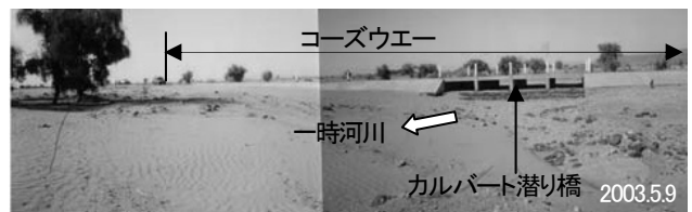
写真-12 モーリタニア コーズウエー凹部に設置された潜り橋
