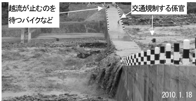
写真-9 インドネシア ジェネベラン川橋梁兼用砂防ダム(越流の様子)
