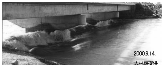
写真-3 カンボジア国道6号線盛土道路を挟んで生じた水位差
