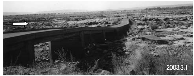
写真-10 マリ ニジェール川で乾季に供用中の潜り橋
