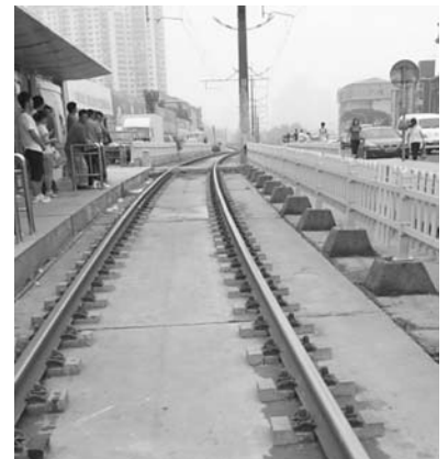
図-7 コンクリート製の軌道
