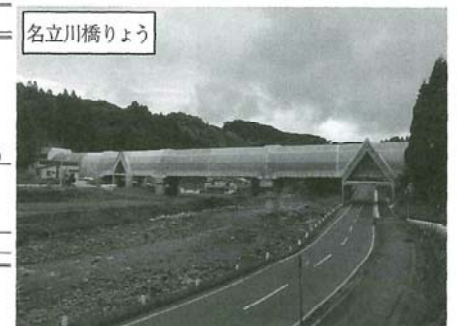
写真 - 1 PC シェルター桁
