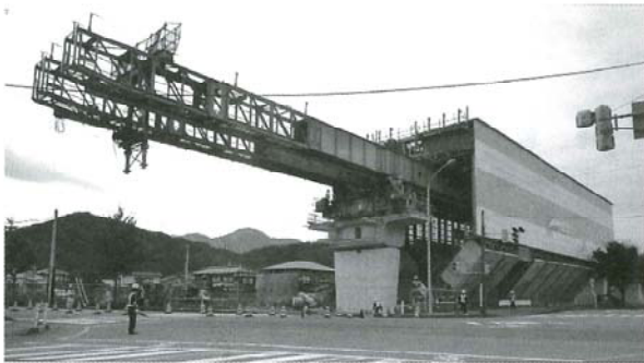
写真 - 4 移動式支保工架設状況
