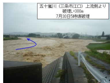
写真-2 五十嵐川上流右岸・江口破堤箇所(図-3参照)
