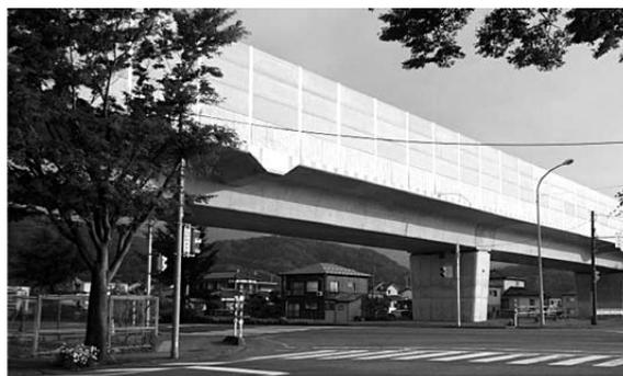
写真-7 国道部 主桁架設完了
