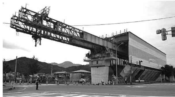
写真-5 移動支保工 架設状況
