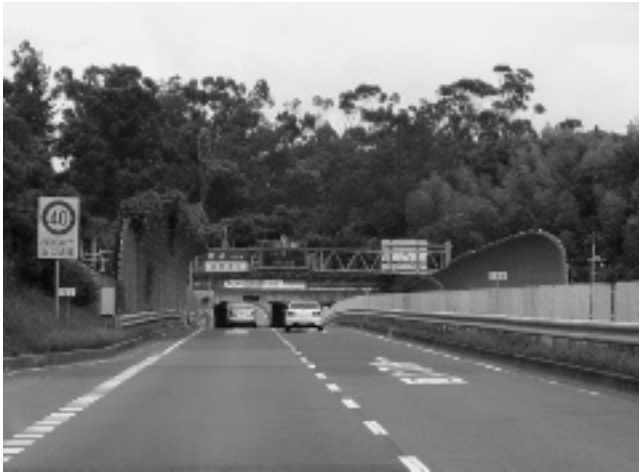
写真－1 宝来トンネル坑口付近の様子
