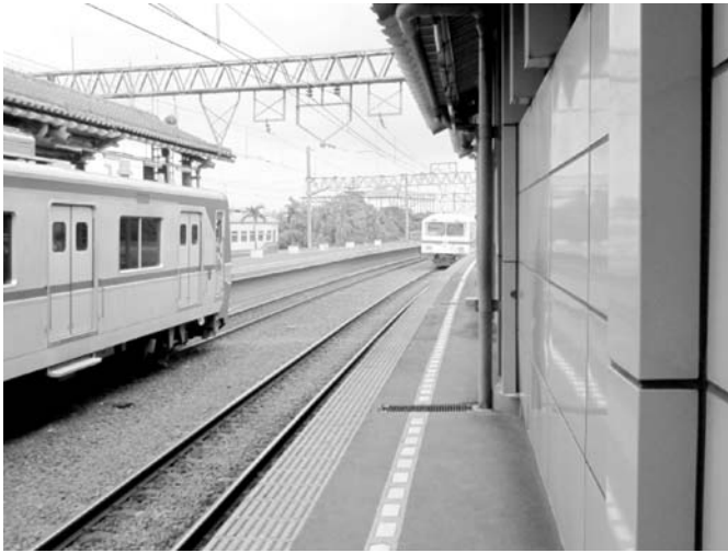
写真-5 ガンビール駅構内
