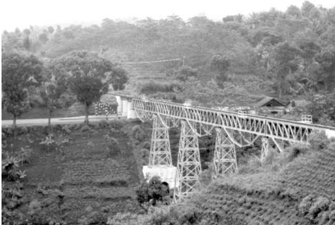
写真-7 下部トラス構造
