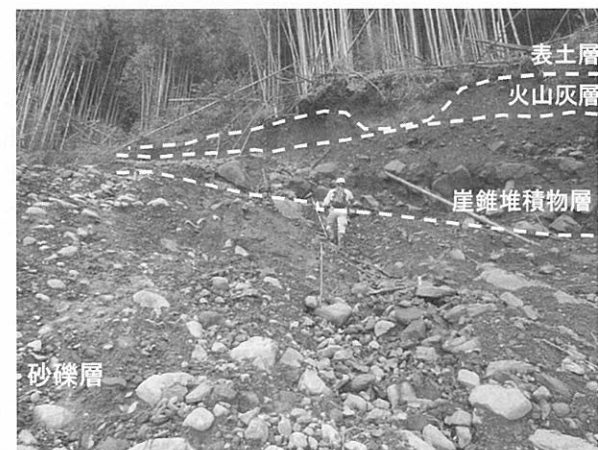
写真-5 滑落崖の状況
