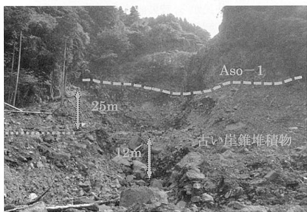
写真-14 滝下の古い崖錐堆積物の削剥
