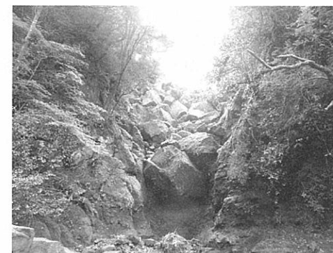
写真-8 溪流内の巨石の堆積状況例 (塩井川1)
