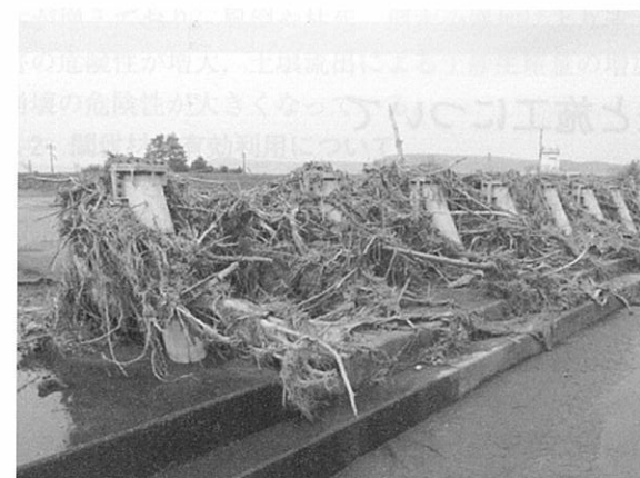
写真-21 一の宮多目的貯木池 (熊本県管理)
