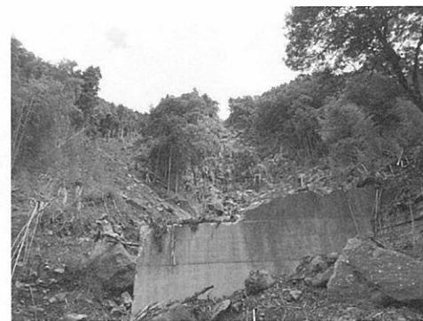
写真-6 崩壊型土石流の例 (塩井川1)
