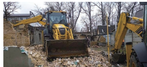
重機によるがれき処理
