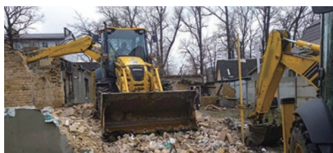
重機によるがれき処理
