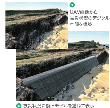
デジタル技術を活用した被災状況や災害復旧の可視化
