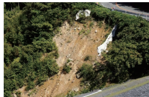
危険を伴う災害復旧現場
