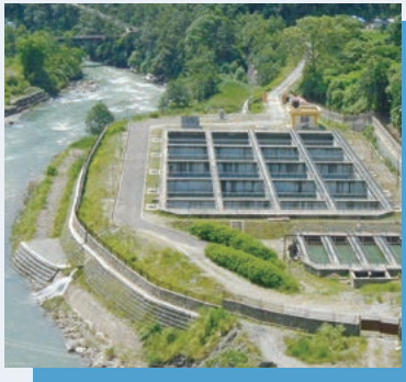
浄水施設の一部である沈砂・沈殿池
