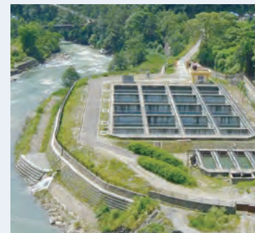
浄水施設の一部である沈砂・沈殿池
