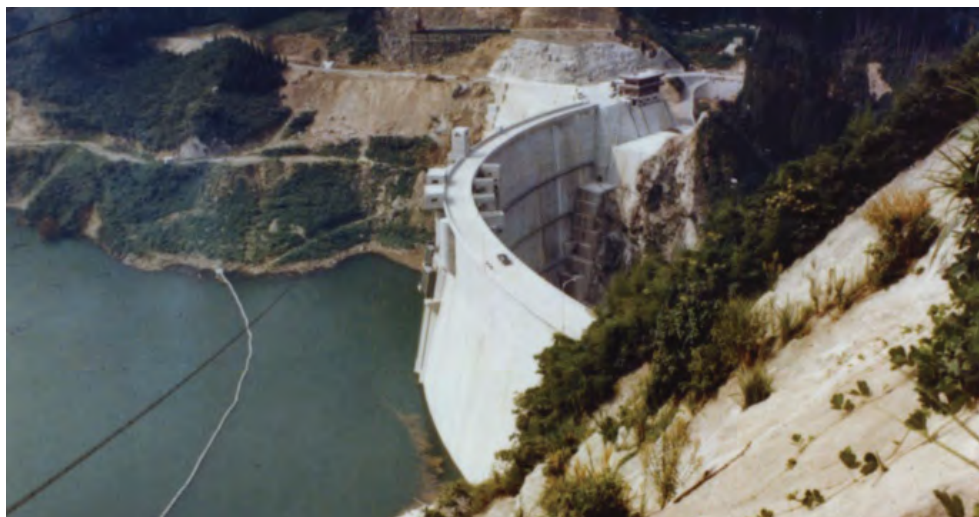
下釜ダム。1965年。地質調査、クラウド試験、岩盤せん断試験基礎処理技術の開発を行った
