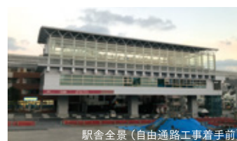
駅舎全景(自由通路工事着手前)
