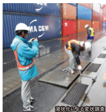
液状化による変状調査
