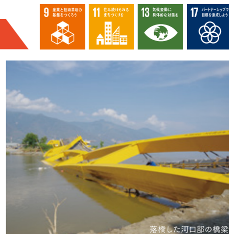
落橋した河口部の橋梁
