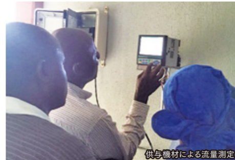
供与機材による流量測定
