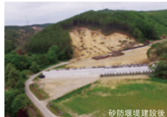
砂防堰堤建設後
