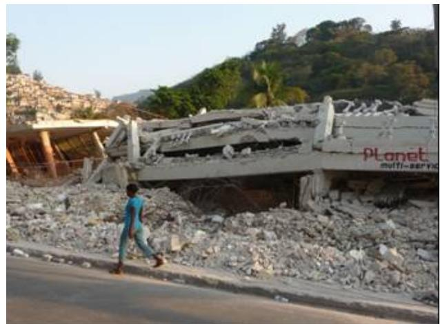
写真-2 1階が倒壊し原形をとどめない建物
