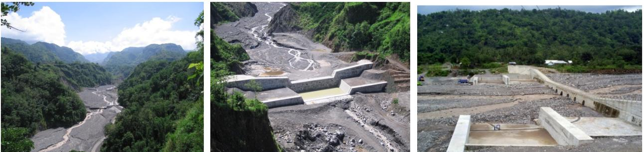
写真-1 防災事業で完成した砂防堰堤の堆積状況
