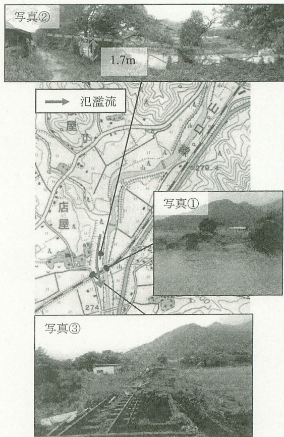
図-5 用路地区 (A1) の被災状況
