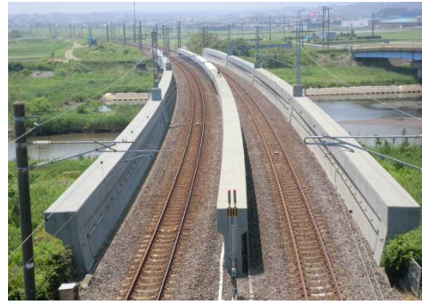
写真2 常磐線大北川橋梁
