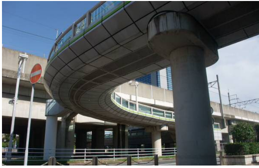
写真-1 幕張モール間デッキ
