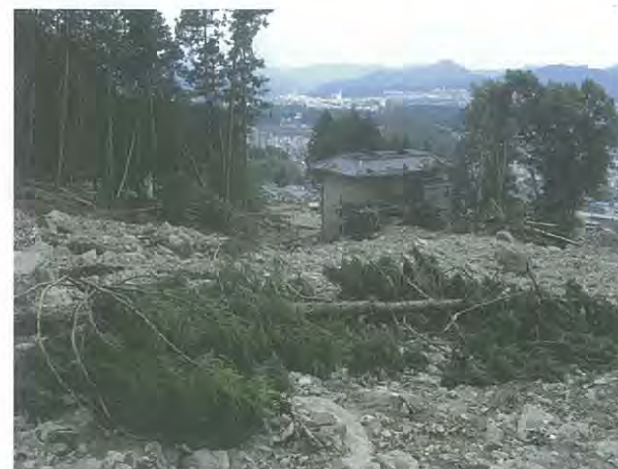
写真-14 五反田川の堆積域の状況 土石や流木は、家屋(倒壊せず)の角にぶつかった
