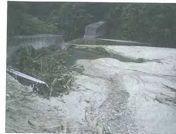
写真-17 砂防堰堤の堆砂状況(安佐北區大林3丁目,下ノ谷川)
