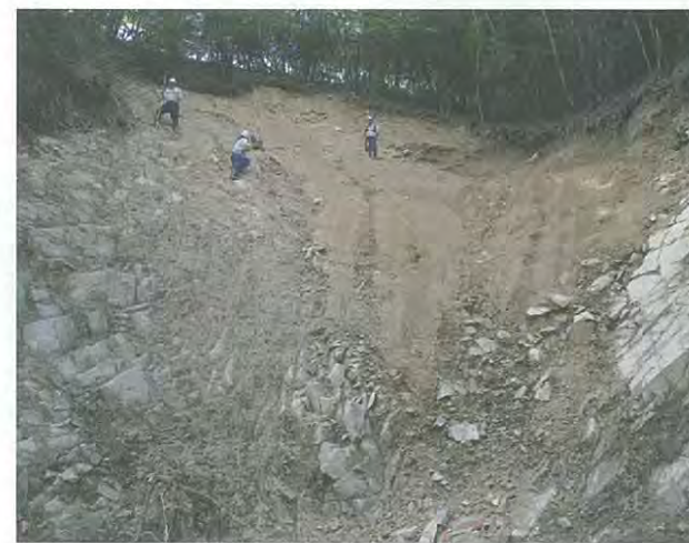
写真-3 根谷川支川 86 の源頭部の崩壊状況。崩壊下部は花崗岩に規制されている
