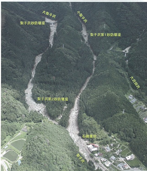
写真-2 梨子沢本川（左）と小梨子沢（中央）の合流点周辺の砂防施設と植生の状況
