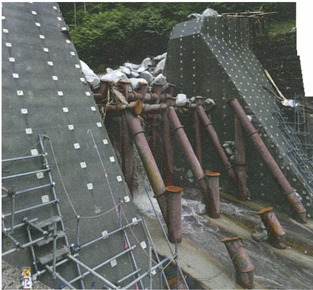
写真-12 梨子沢第1砂防堰堤（右岸下流より望む） Photo 12 Nashizawa dai-ichi sabo dam viewed downstream right-bank
